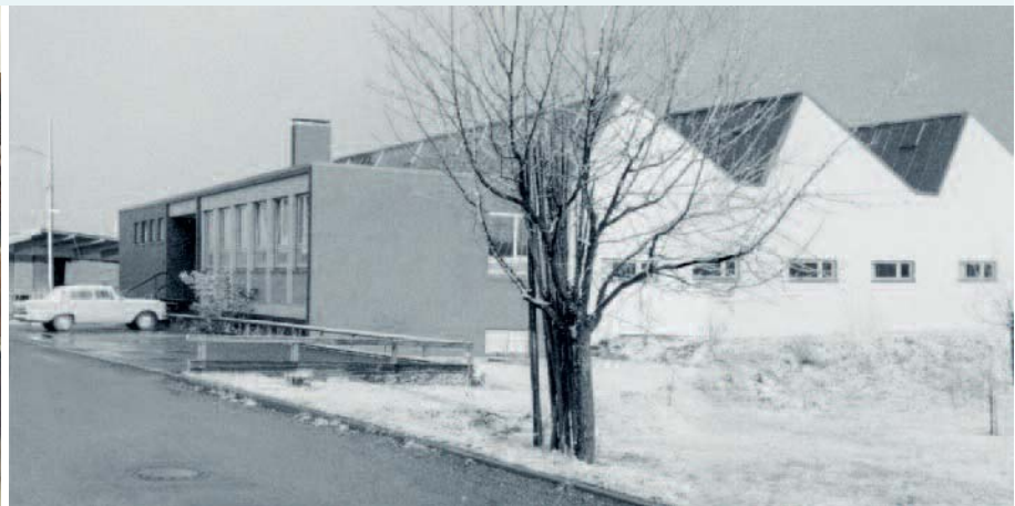
Neubau 1963 in Großheppach im Remstal
